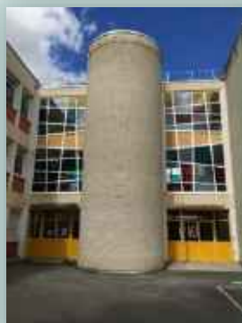
Collège VERLAINE à Saint-Nicolas-lez-Arras : travaux de remplacement des murs rideaux en cages d'escalier A et B.
