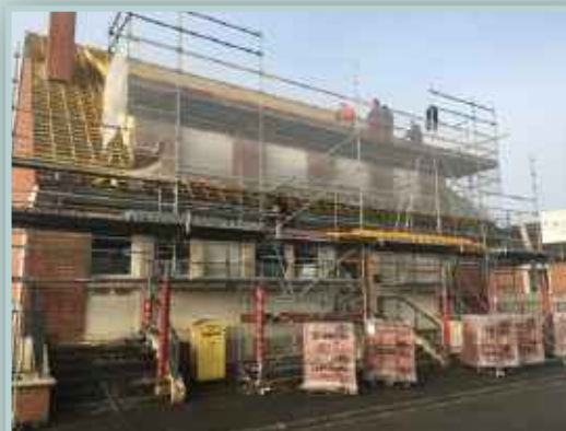
Hôtel des postes à PAS-EN-ARTOIS : travaux de réfection de la couverture du bâtiment principal
