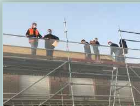
Hôtel des postes à PAS-EN-ARTOIS : réunion de chantier suivant mesures sanitaires COVID.
