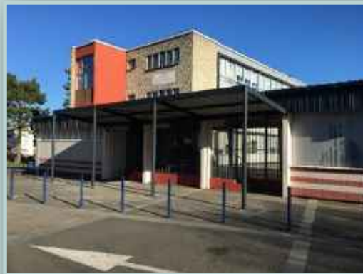
Collège Péguy à ARRAS : travaux de rénovation de l'entrée principale des élèves.
